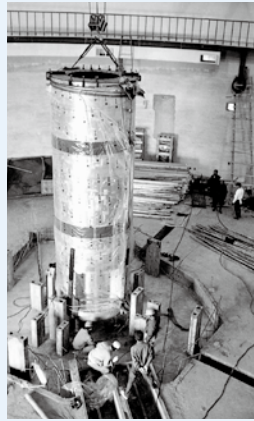
トリカII型原子炉の設置工事。
